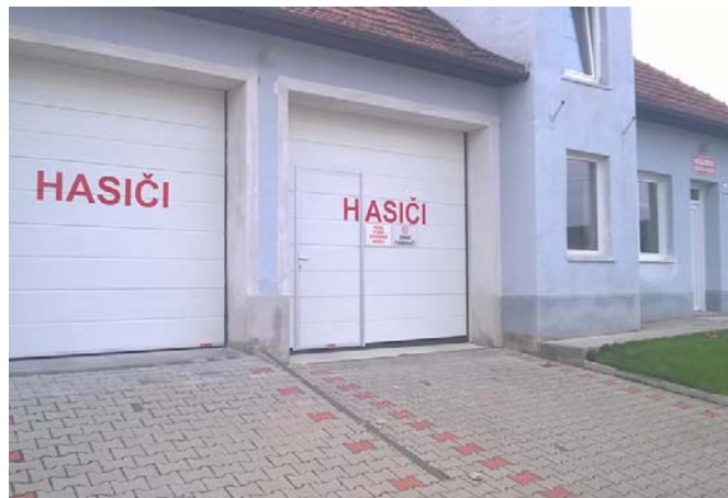
Rekonštrukcia hasičskej zbrojnice – výmena okien a vchodovej brány do garáže
